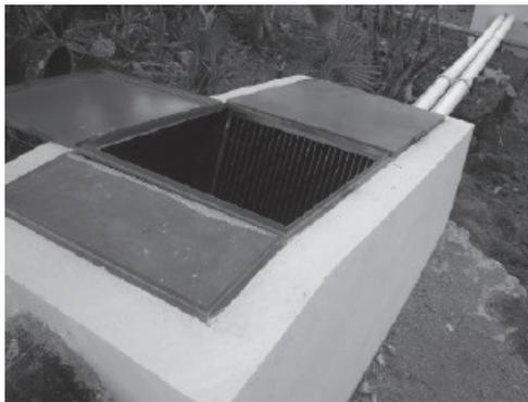
Figura 1. Sistema de rejillas PTAR-UTM
