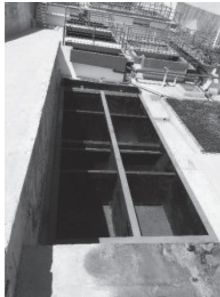
Figura 8. Tanque de filtración PTAR-Acatlima
