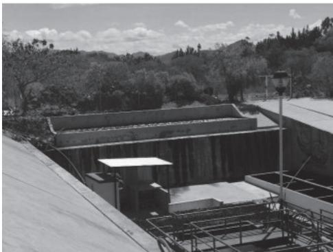
Figura 6. Secador de lodos PTAR-Acatlima
