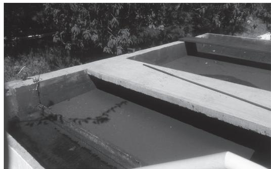
Figura 4. Sedimentador PTAR-UTM
