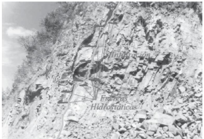
FIGURA NO. 4. CARACTERÍSTICAS DE FRAGILIDAD DE LAS ROCAS, DADAS POR EL GRADO DE FRACTURAMIENTO E INTEMPERISMO.
