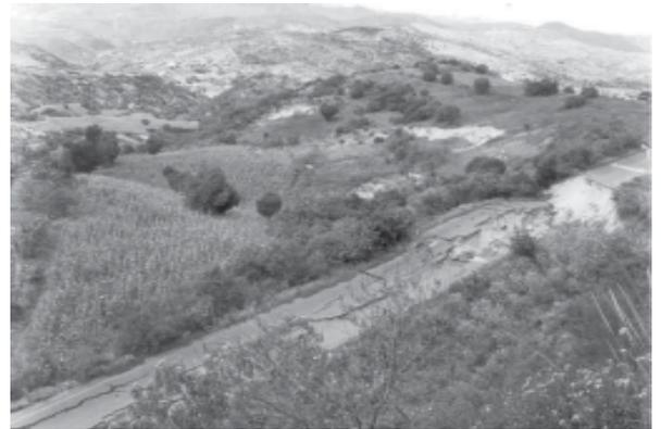
FIGURA NO. 5.- FOTOGRAFÍA DONDE SE OBSERVA EL DESLIZAMIENTO DE LADERAS 4.5M DE DESPLAZAMIENTO LATERAL HACIA EL PONIENTE, 6.5M DE PROFUNDIDAD Y 1.65M DE LONGITUD UBICADO AL NORTE DEL MUNICIPIO DE IXPANTEPEC NIEVES, SILACAYOAPAN, OAXACA.
